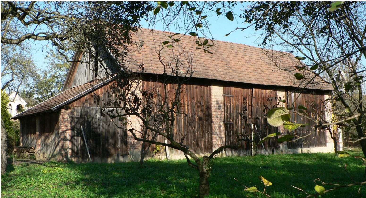
Vakolatlan, téglapilléren álló, deszkázott oldalú lábas pajta, cserépfedésű nyeregtetővel
