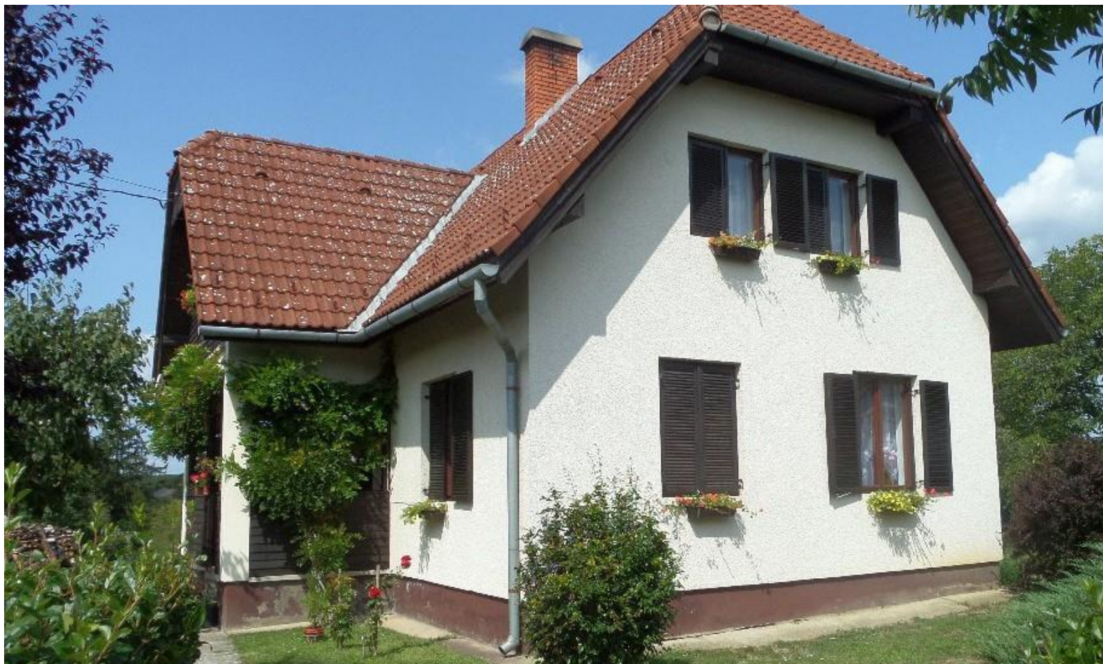
Új ház arányosan szerkesztett homlokzattal és nyílászáró elrendezéssel
